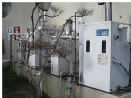
故障した給湯ボイラー
