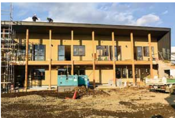
新園舎工事中!!
