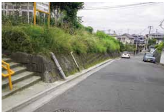
震災後の擁壁
