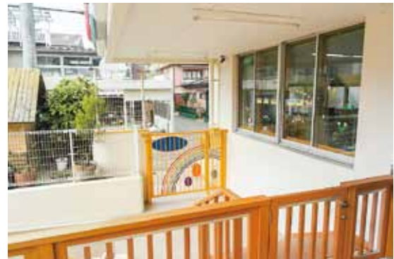
玄関前スロープ
