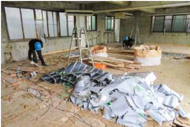
ホールの解体・仕分け作業
