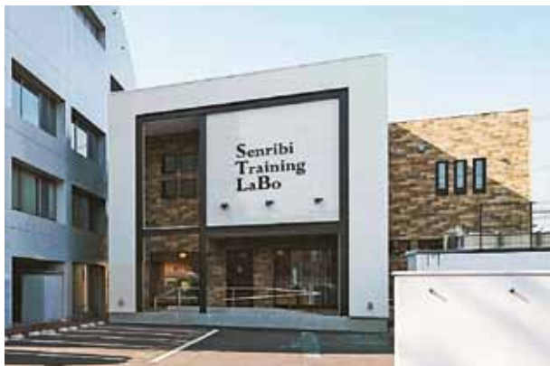
トレーニング・ラボの外観。イメージは、アーバンで「オトナカッコいい」サロン。
