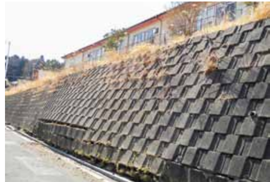
旧仙台市中山保育所擁壁 (地面が動いたため今にも崩れ落ちそうな擁壁)
