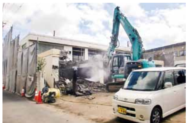
旧園舎解体 そして、新たなスタートへ
