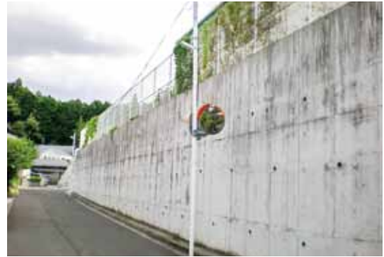
仙台市中山保育所 新擁壁
