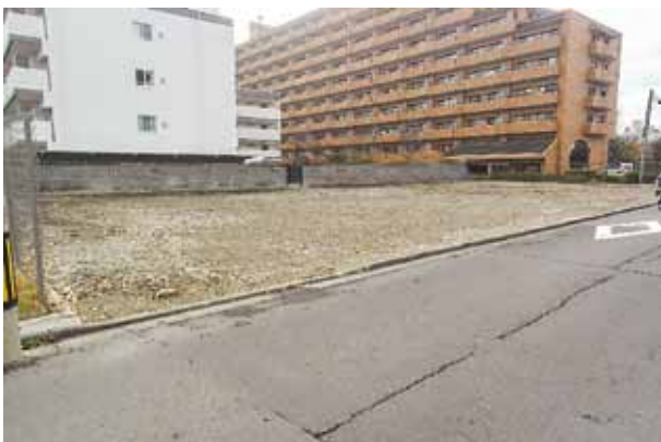
校舎の解体工事が終わり、まっさらの更地に。
