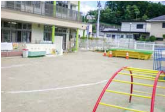
仙台市中山保育所 新園舎 (園舎も園庭もすっかり新しく、擁壁も高さも増し、強固なものに。)
