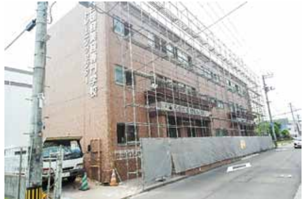
いよいよ解体工事が始まります。
